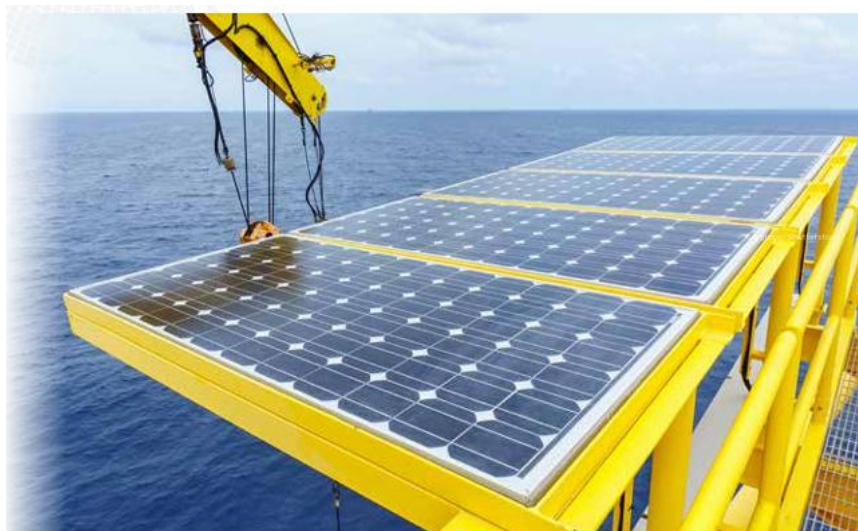
Рис. 4. Установка фотоэлектрических модулей на вынесенных консолях
