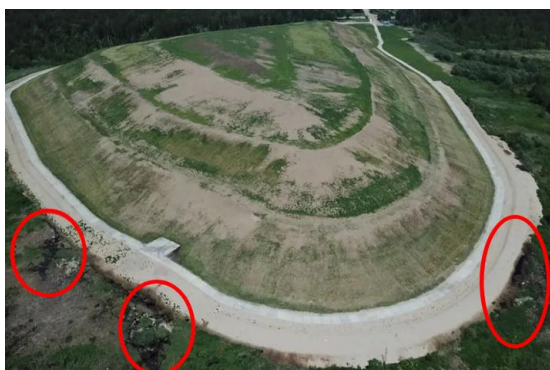
Рис. 2. Разлив фильтрата на полигоне г. Калининграда после рекультивации [По: http://www.newkaliningrad.ru ]
