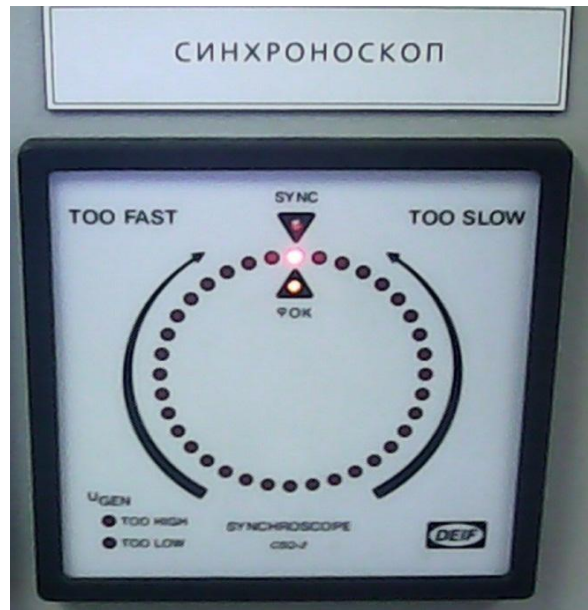
Рис. 4.8. Микропроцессорный светодиодный синхроскоп в положении параллельной работы
