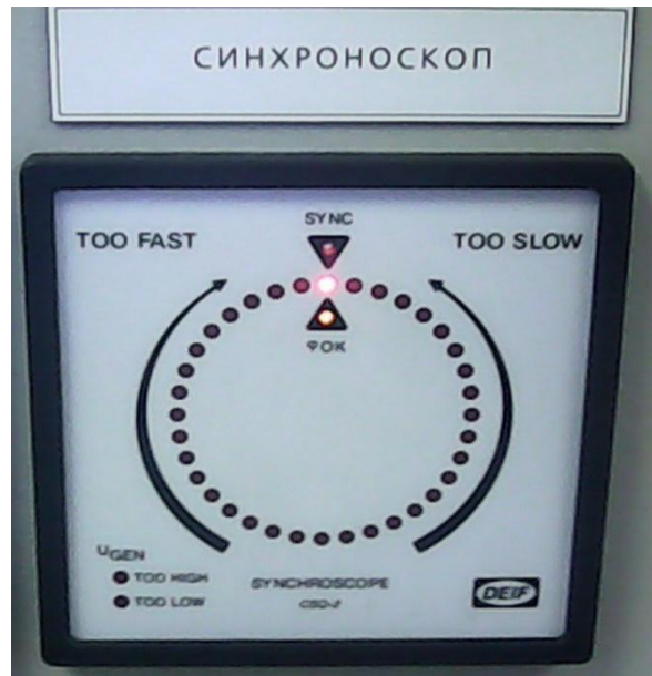
Рис. 5.11. Микропроцессорный светодиодный синхроскоп в положении параллельной работы
