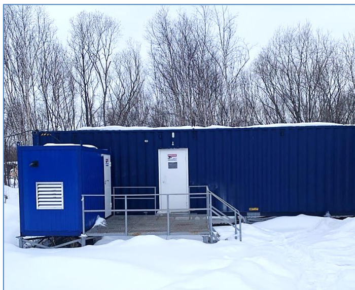
Рис. 1. Модульная станция очистки воды «БМВО-10»
